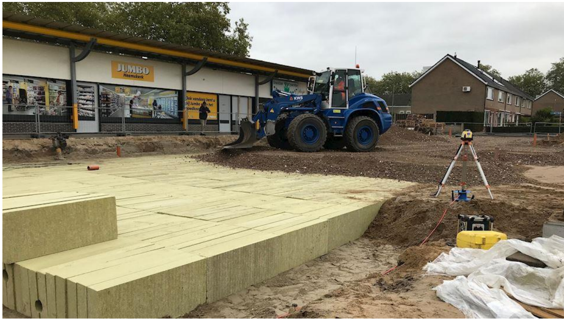
Figuur 4: Aanleg rockflow onder parkeerterrein (Lapinus, 2020)
