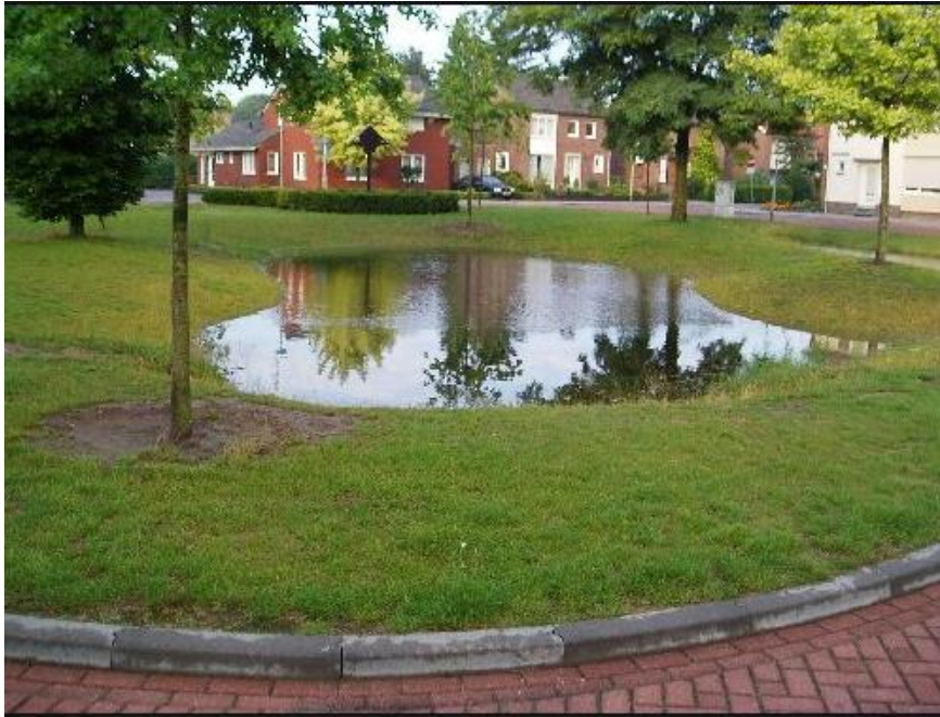
Figuur 3: Een met hemelwater gevulde wadi (Vree, 2016)
