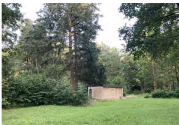
Een sanitair gebouw uit vervlogen tijden op het terrein.
