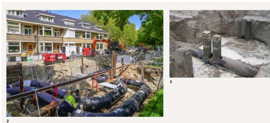
Figuur 3.1 in Plan Amsterdam- Druk op de ondergrond 03 | 2019 zijn bovenstaande figuren opgenomen die laten zien dat de aanleg van stadswarmtenetten ingrijpend is en veel ruimte inneemt. De rechterfoto laat zien dat het ook mis kan gaan 27 .
