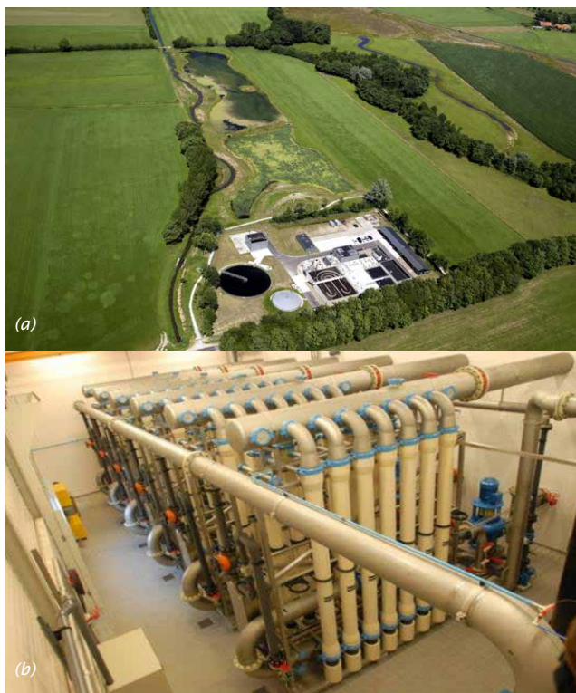
Figuur 3.3: rwzi Ootmarsum: (a) hybride MBR system (foto: waterschap Vechtstromen & Sweco); (b) side-stream MBR-installatie (foto: waterschap Vechtstromen & Pentair X-Flow).
